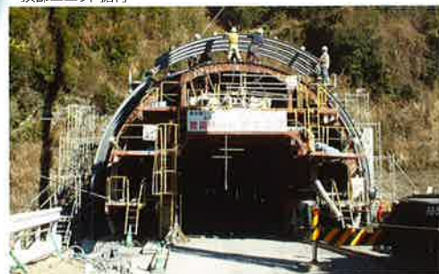
頂部ユニット据付
